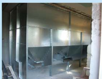
Kuvassa 10 m³ pellettisiiliön asennus omakotitalon kattilahuoneeseen.
