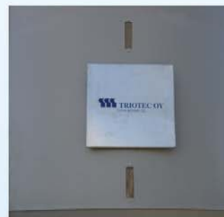
Miesluukku ja tarkastusikkunat
