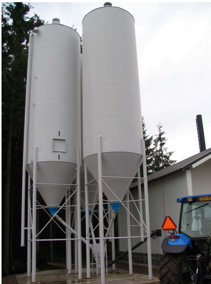
Kolme 29 m 3 siiloa yhdistettynä välisäiliöllä
