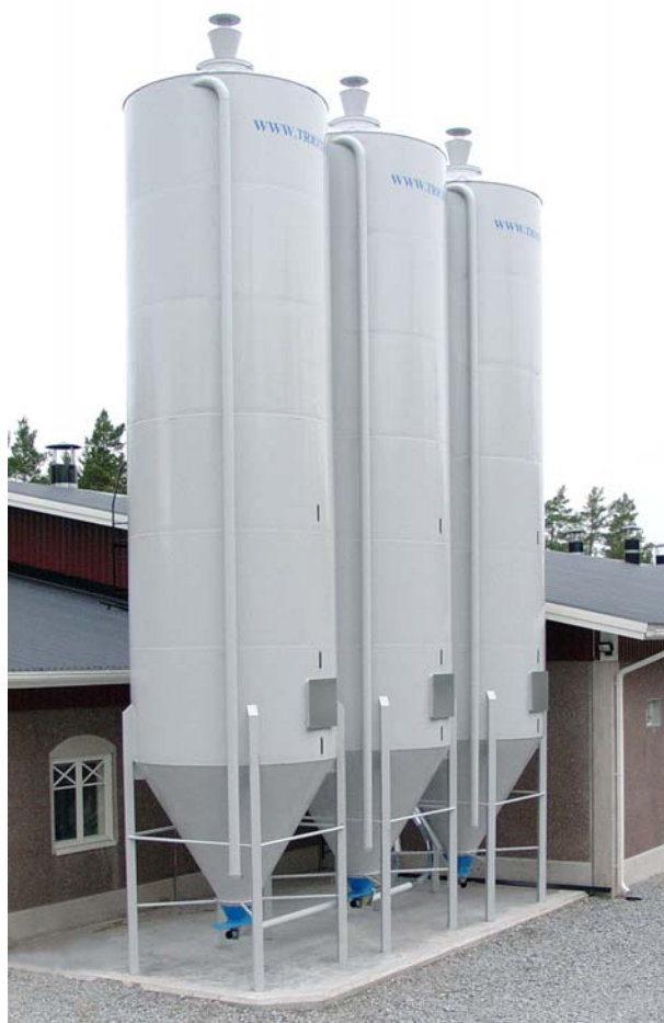
Kuvassa kolme Triotec 34m 3 ulkosiiloa kolmella siirtospiraalilla
